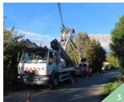
Le poteau qui pliait sous le poids de nombreux câbles a finalement été changé par un poteau fer. Les câbles sont donc plus hauts pour le passage des véhicules agricoles et autres. Photo 3
